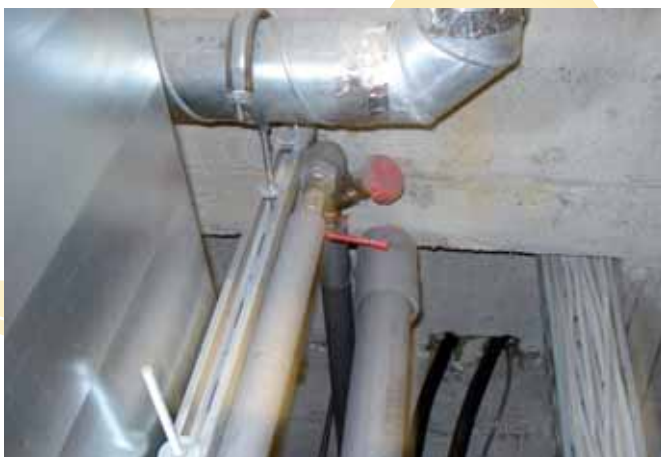
Skrytý uzavřený okruh systému cirkulace horké vody, který poskytoval prostor pro růst bakterie Legionella – Zdroj: OMF1.
